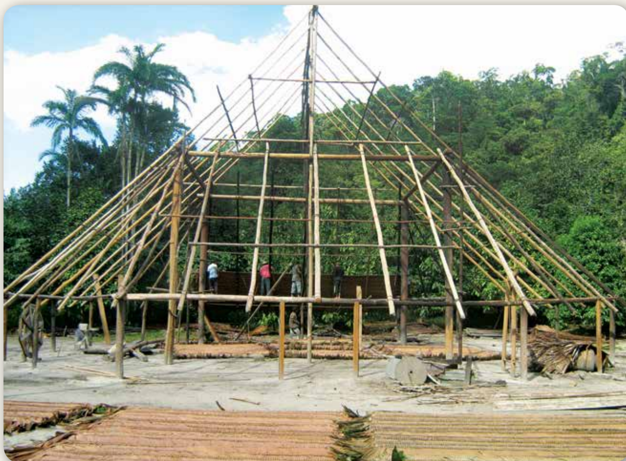
Construcción de maloca propia del área cultural muinane y andoque en la región central del río Caquetá. Tropenbos Internacional, Colombia.
